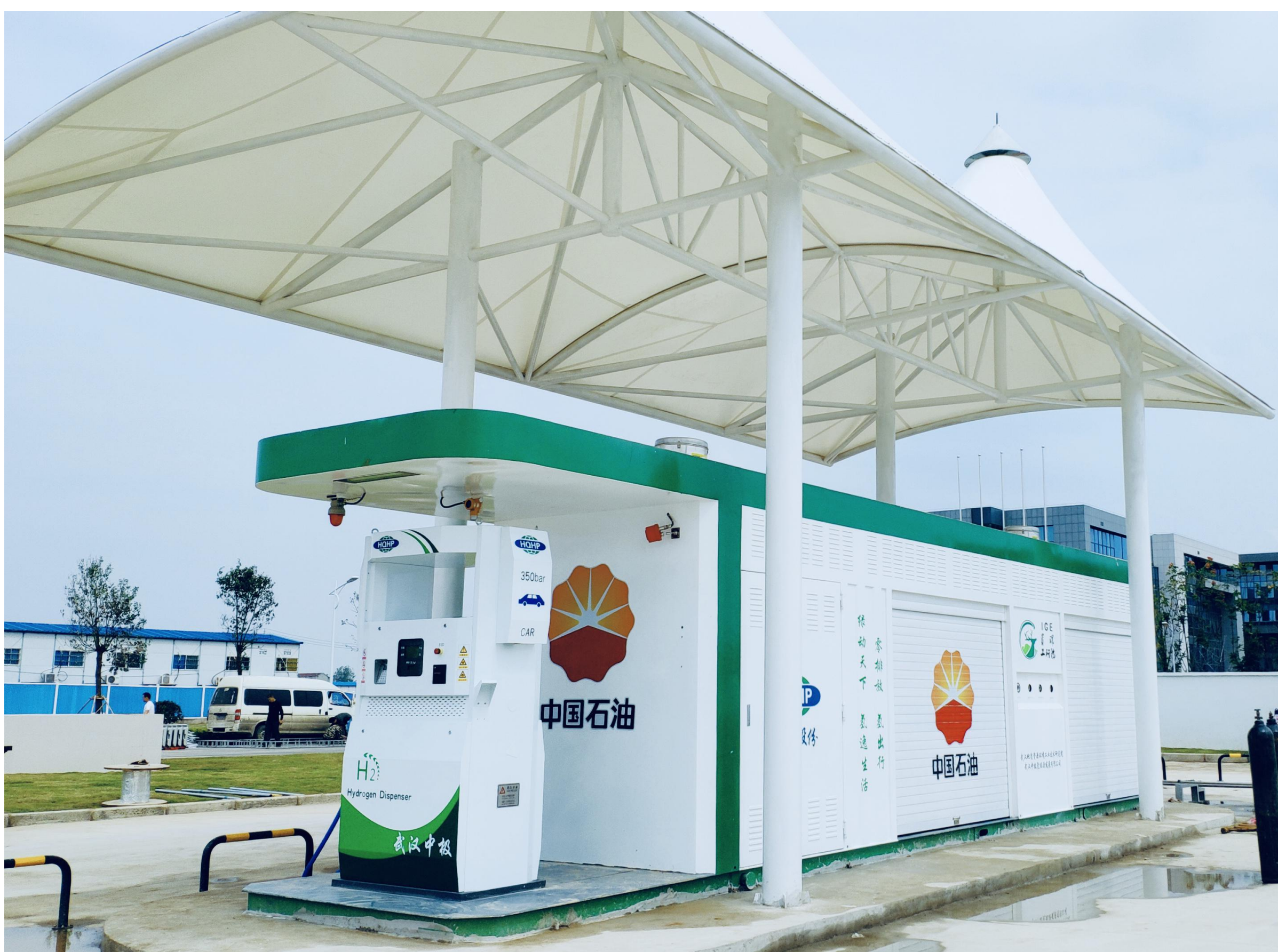
35MPa加氢成套设备应用于 湖北武汉中极加氢站
