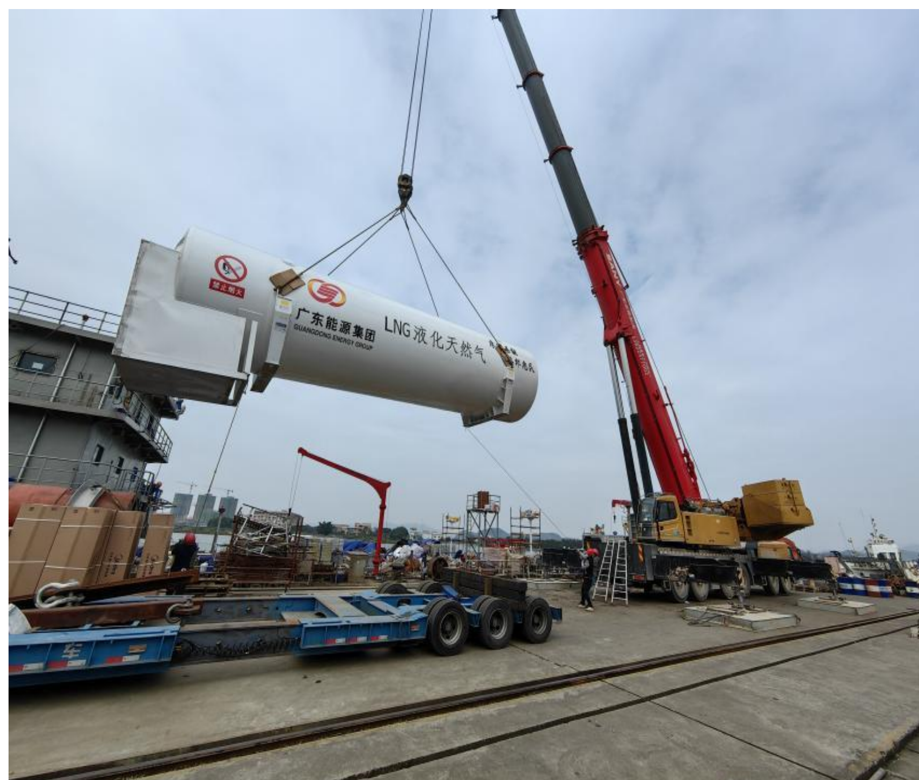
2023年1月3日现场储罐吊装
