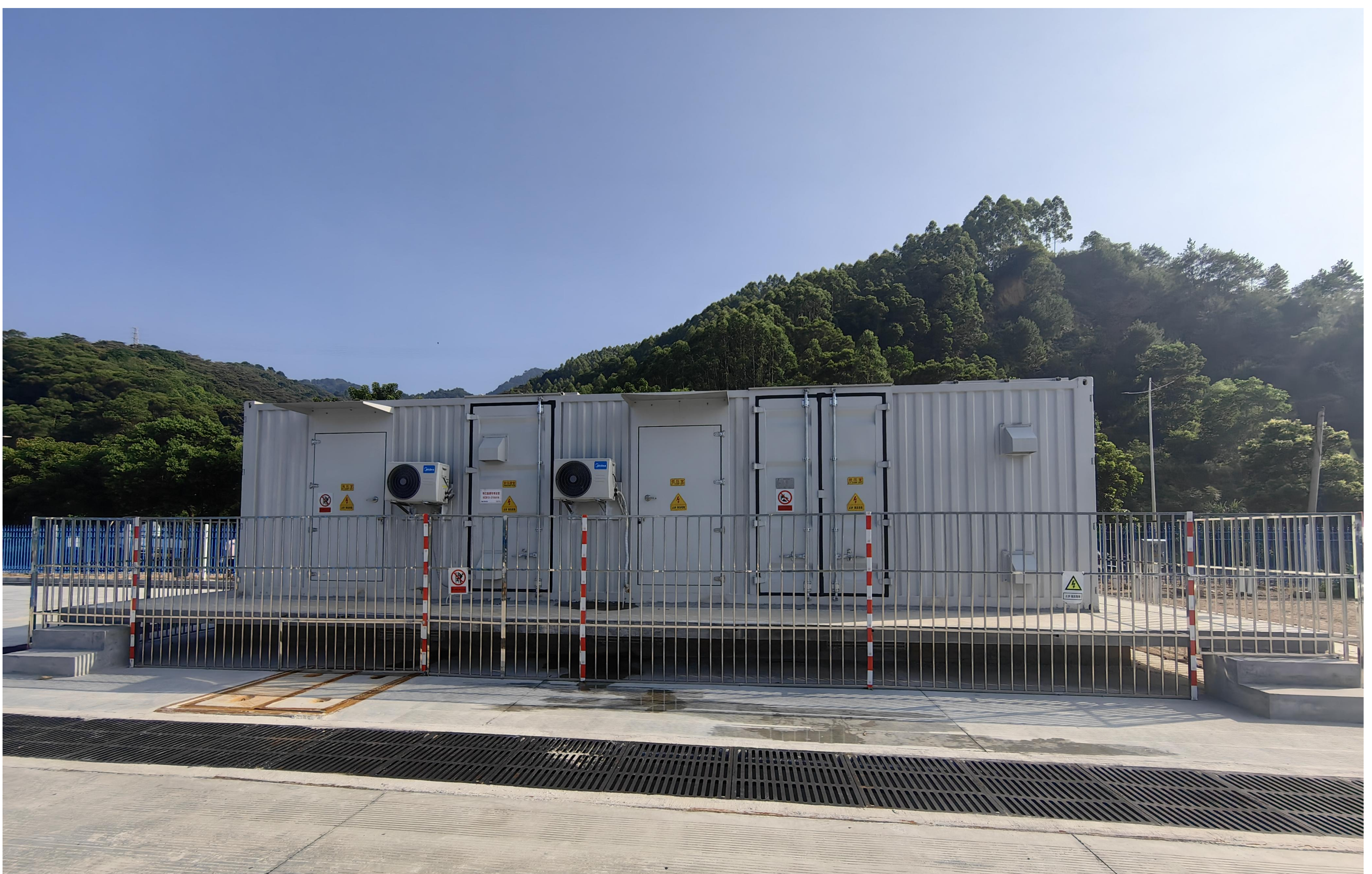
2023年6月30日，岸基部分卸车系统安装完成
